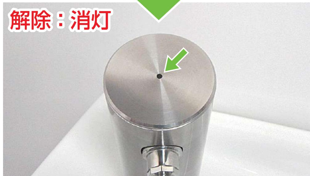
リセットスイッチを押して薬液を供給し、「薬液切れ状態」を解除します。
