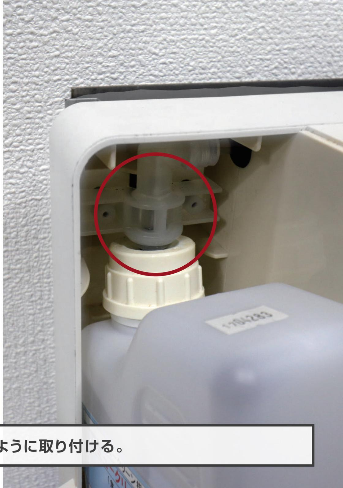
ボトルカップをノズルとの間に隙間がないように取り付ける。
